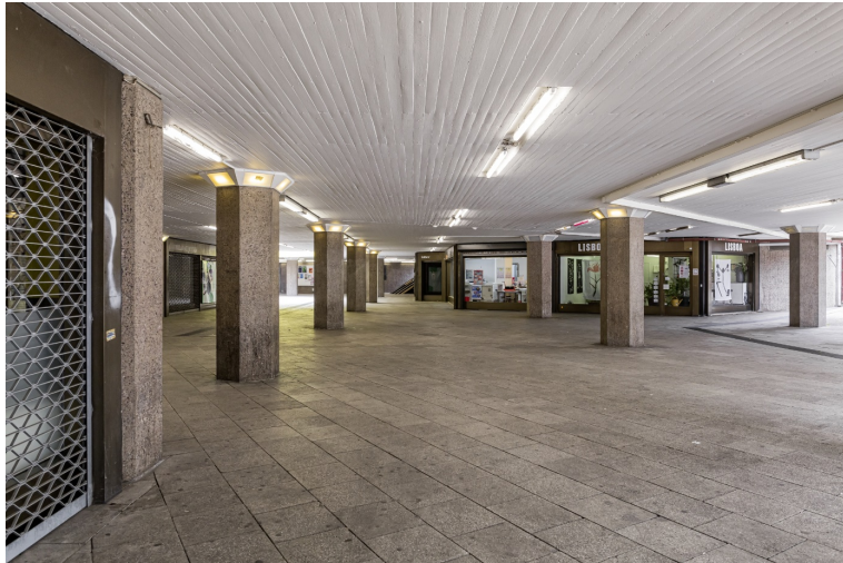
Abbildung 2: Blick durch die Ladenpassage. Die Decke war ursprünglich betonsichtig und durch die gut sichtbaren Schalungsbretter in ihrer Laufrichtung betont. Foto: Viola Blumrich, LVR-ADR, 2019.
