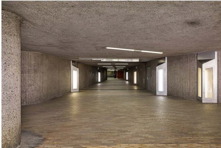
Abbildung 9: In der Verbindung zur U-Bahn ist dem Sichtbeton Tuffmehl beigeetzt, was eine feine Oberfläche mit einem warmen beigen Ton verleiht. Foto: Viola Blumrich, LVR-ADR, 2019.
