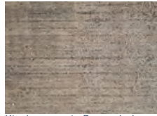
Kiesbeton mit Brettschalung
