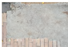
Flickarbeiten mit Kaltasphalt
